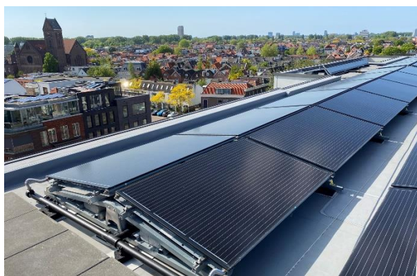
Voorbeeld van een pladdak-opstelling op een appartementencomplex in Delft.
