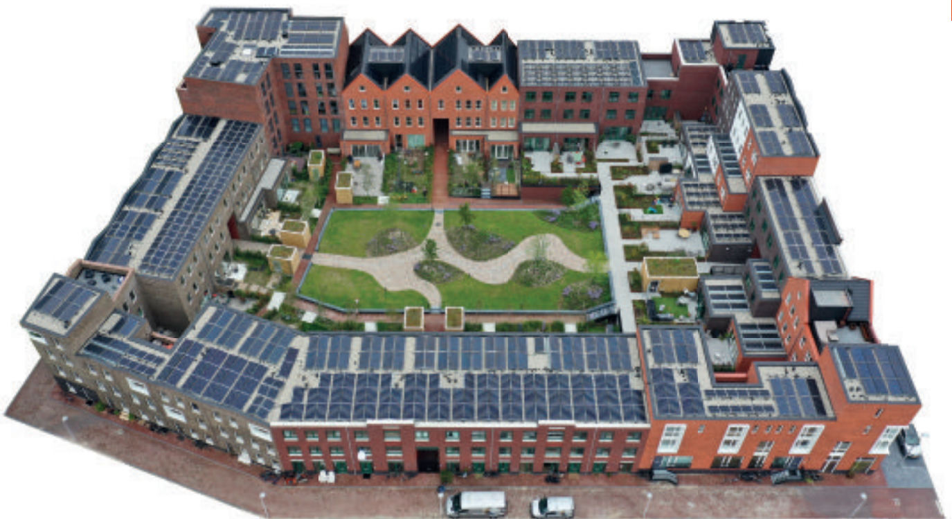
Project Ronduit Utrecht - 40 energieleverende woningen met PVT-panelen als bron, aangevuld met gewone PV-panelen
