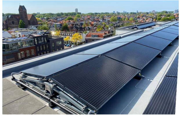
Voorbeeld van een platdakopstelling op een appartementencomplex in Delft.
