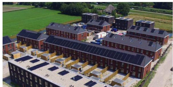
Voorbeeld van een schuindakopstelling op een woonblok in Heerhugowaard
