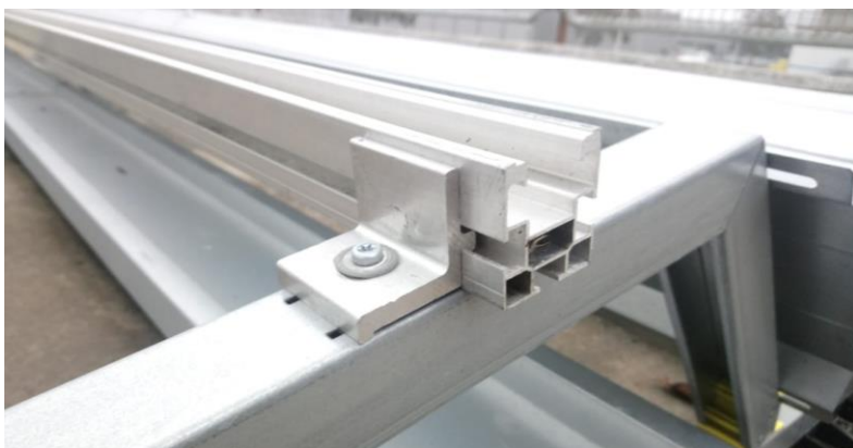
Figuur 6.0 – kruisverbinder welke montagerail vastklemt op Sunbeam montagesysteem
